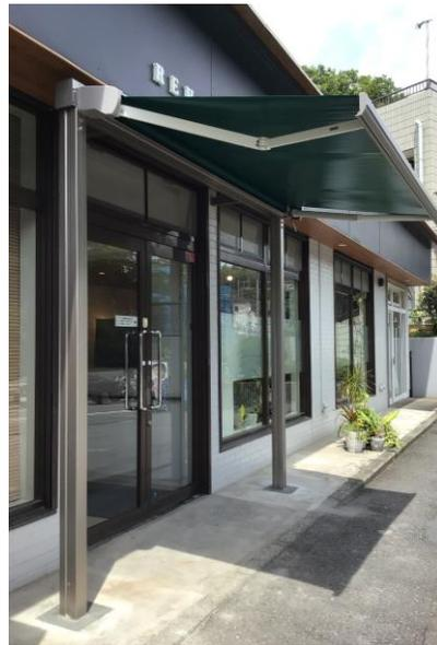
雨よけと日よけ対策として、開閉式のオーニングを出入口に設置しました。
